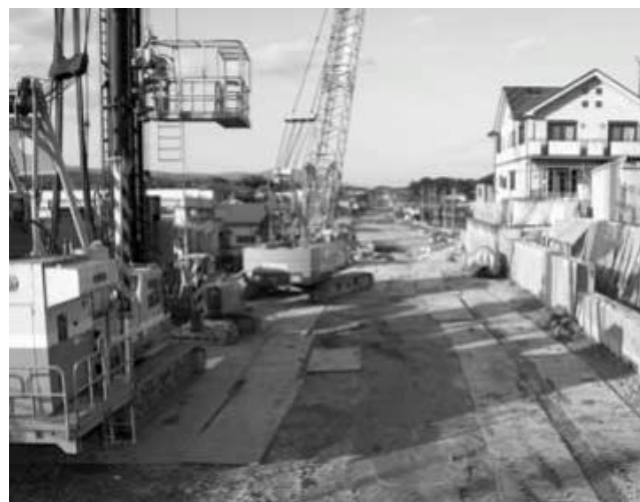
北今市3丁目西交差点南側工事の様子(平成19年)
